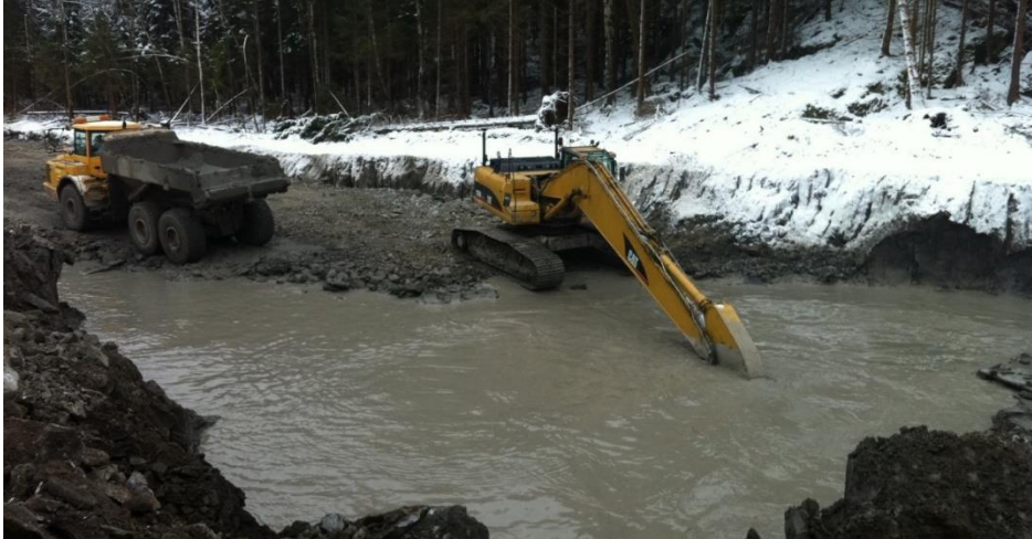
Figur 3-2. Undervattensschakt, E45 Trollhättan (Foto J. Wallgren)
