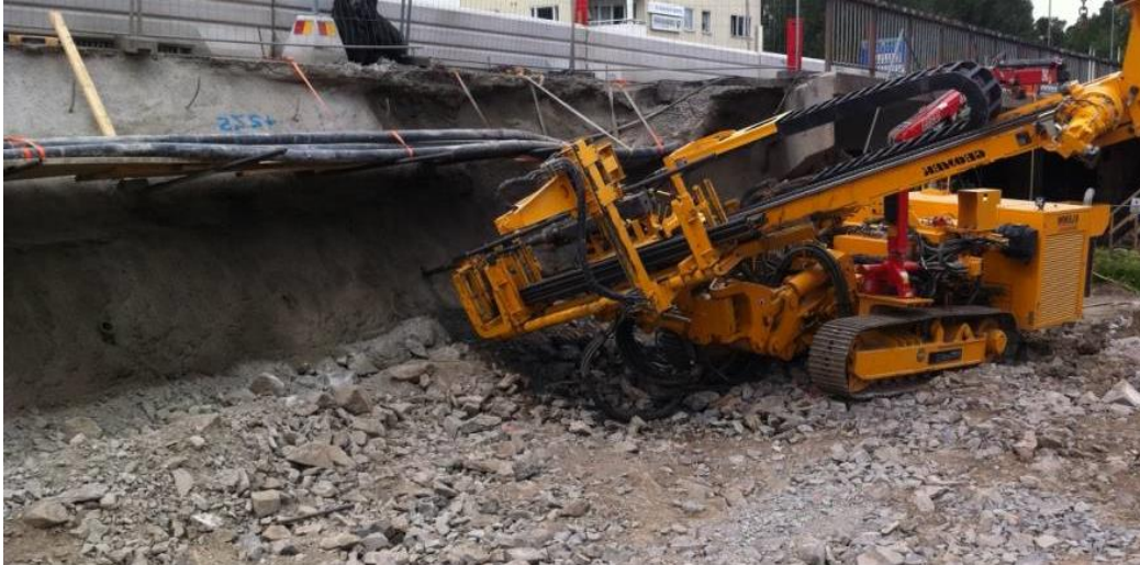
Figur 3-4. Borrning av jordstag vid jordspikad slänt. Rovan 5, Solna. (Foto O. Lidehorn)
