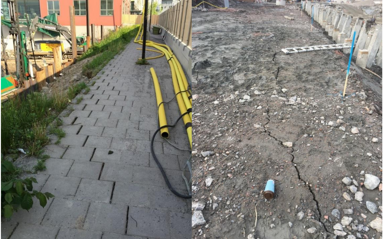
Figur 4-3. Sprickbildningar vid spontrörelse (vänster bild) respektive släntrörelse (höger bild) (Foton M. Sabbatini).
