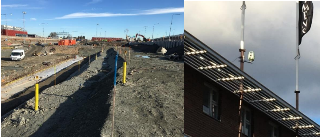
Figur 4-1. Vänstra bilden visar exempel på mätpeglar (foto M. Sabbattini). Högra bilden visar exempel på monitorering med totalstation (foto H. Möller).
